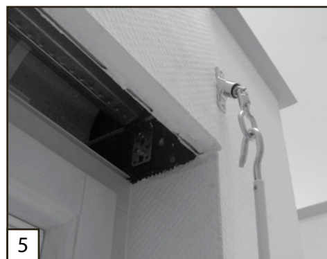
5. lépés Kész! Most már rá tudja akasztani a kurbli, a szemre és áramszünet esetén is tudja árnyékolóját mozgatni a kurbli segítségével.
