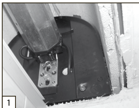
1. lépés Elsőként telepítse a motort a redőnytokba.
